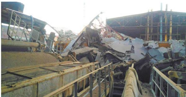
*Einsturz des Flachdachs mit einer Fläche von 3.500 qm einer der Hallen des Unternehmens „Krimert Titan“ (Hersteller von Titandioxid), August 2017*
