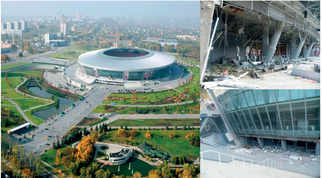
„Donbas Arena“ ist ein Stadion, das 2009 im Zentrum von Donezk im Rahmen der Vorbereitung zur Euro-2012 eröffnet wurde. Rechts: Die Zerstörungen am Stadion, die durch die Kampfhandlungen 2014 entstanden sind.
